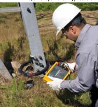
Защелкнуть трансформатор с разрезным сердечником на опоре линии электропередач для измерения контура заземления
