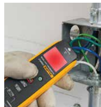
Быстрая проверка наличия напряжения без прикосновения к проводу под напряжением.
