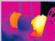
Перегрев крышки подшипника
