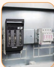
Rozłącznik LTL00 z aparaturą modułową
