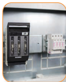
Rozłącznik LTL00 z aparaturą modułową
