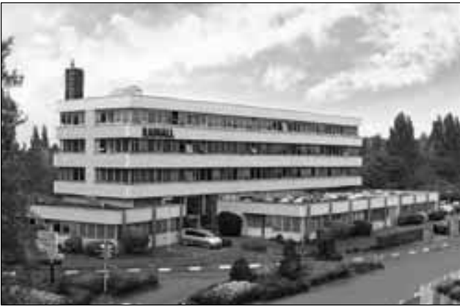
Head Office - Rosny sous Bois
