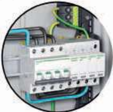
Ogranicznik przepięć iPRD 3P+N + iC60N 3P+N
