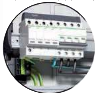
Ogranicznik przepięć iPRD 4P + iC60N 4P
