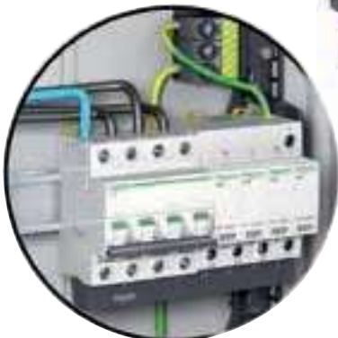
Ogranicznik przepięć iPRD 4P + iC60N 4P
