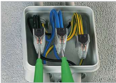
Измерение напряжения через отдельные тестовые гнезда.
