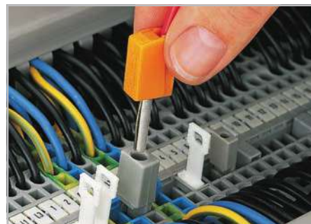
Использование бананового штекера в качестве тестового – тестирование с помощью тестового адаптера 209-170.
