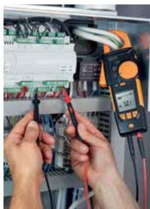
Измерение напряжения в распределительном щитке теплового насоса путем подвешивания прибора.
