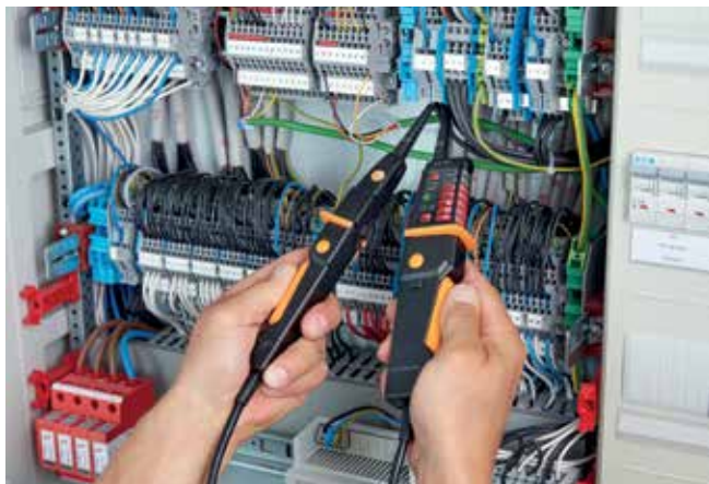
Измерение напряжения в распределительном щитке.
