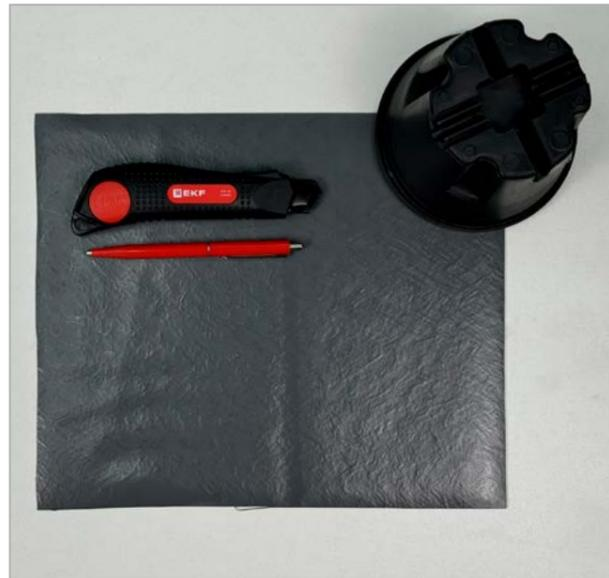
**Шаг 2.** Для начала в центре отрезка ПВХ-мембраны размером 25 x 25 см размечаем окружность, для этого обводим верхнюю часть держателя
