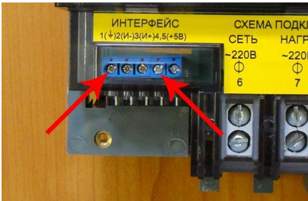
Рис. 15 Клеммы счетчика Меркурий 200 для подачи питания интерфейса
